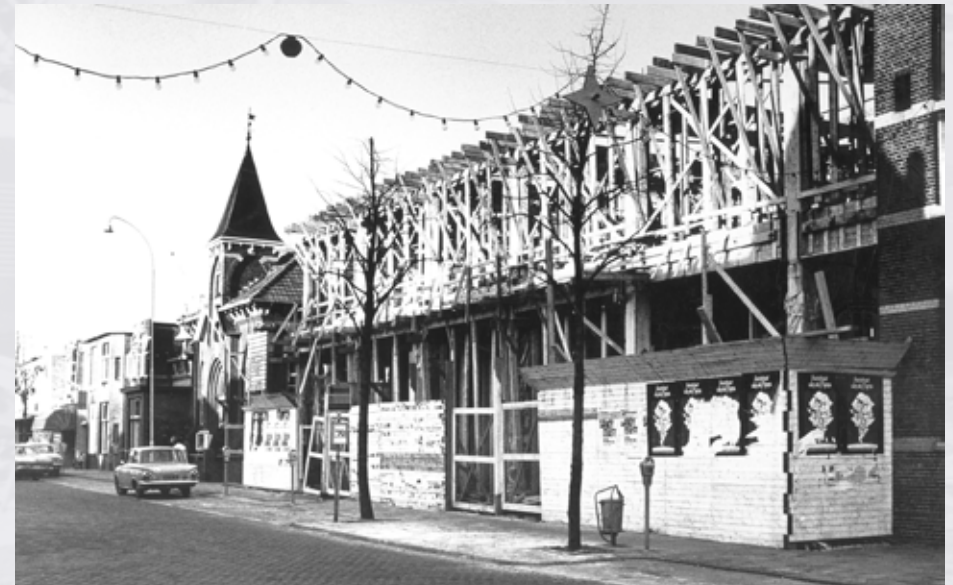
Aanvang van de nieuwbouw ter realisatie van het huidige postkantoor aan de Damlaan in 1970. Bron: Gemeentearchief Leidschendam-Voorburg
