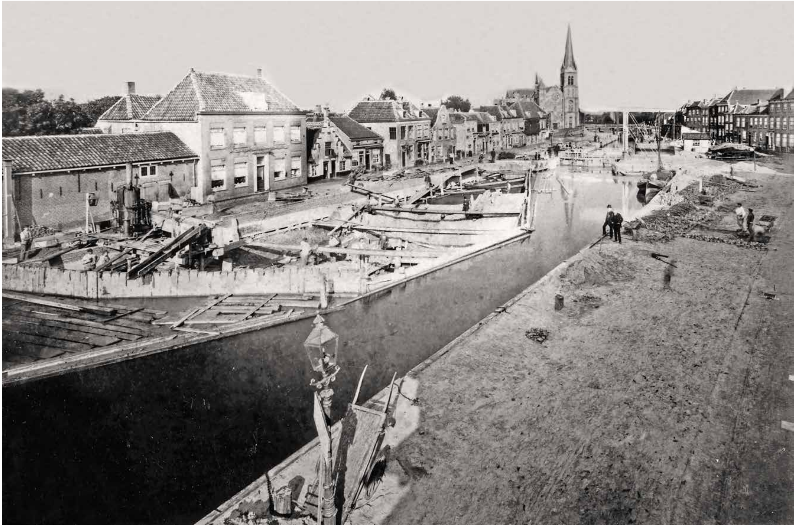
Aanleg van het nieuwe sluiscomplex gezien in noordelijke richting met links de Sluiskant met in het midden de HH Petrus en Pauluskerk en rechts de Delftsekade, 1887. Bron: beeldcollectie Leidschendam-Voorburg.
